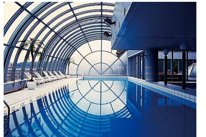
屋 内 温 水 プ ー ル
