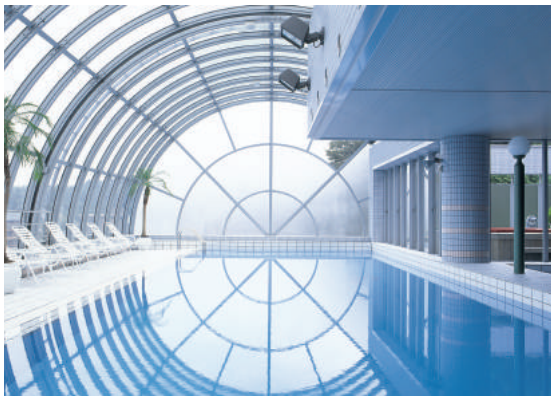
開閉式屋内温水プール
