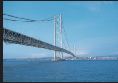
明石海峡大橋
