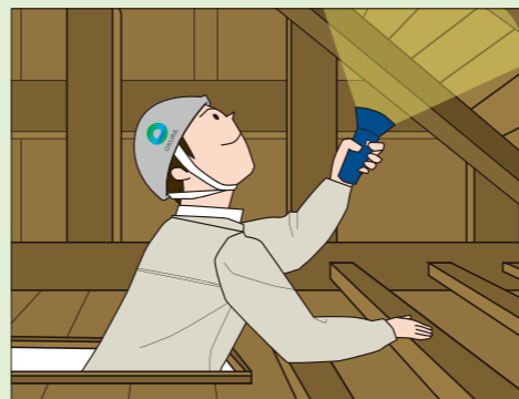
屋根裏の調査
